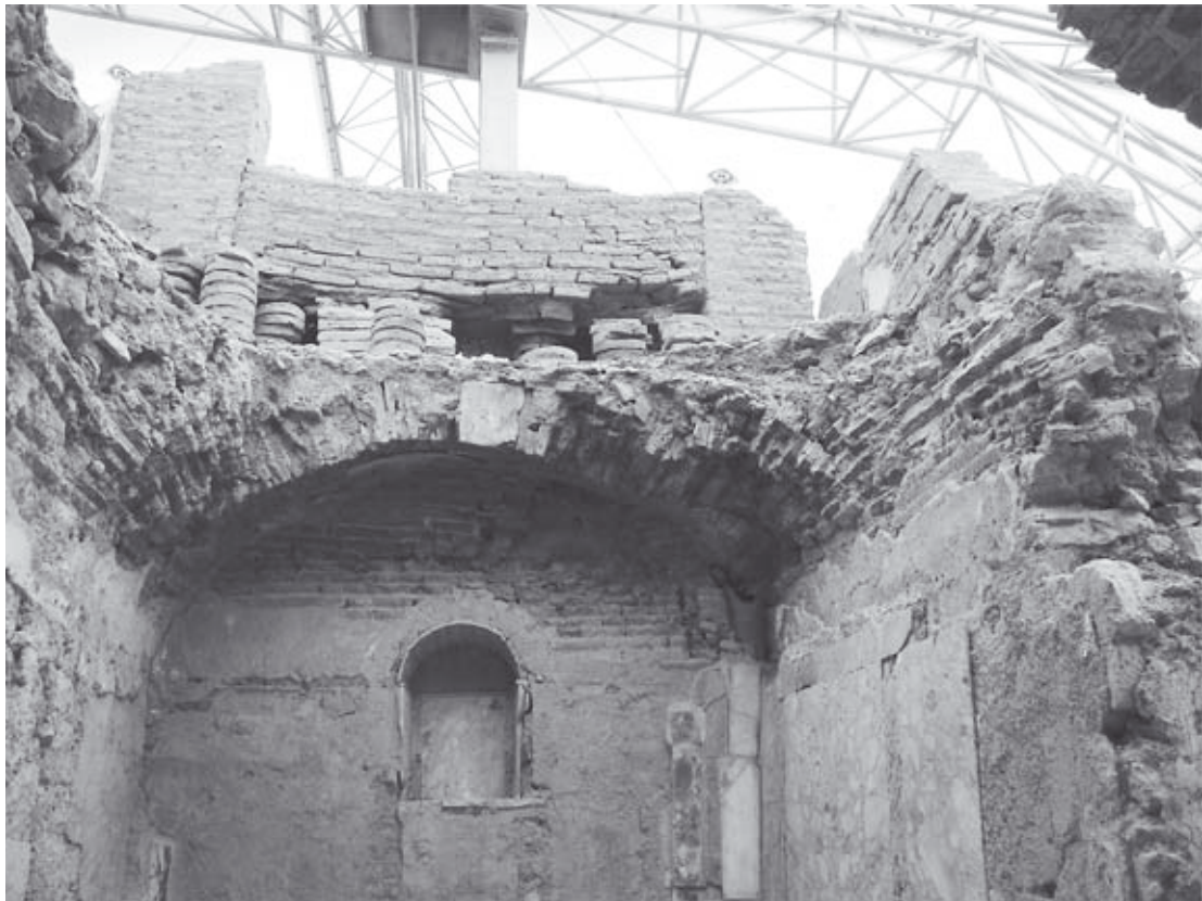
Abb. 4: 36c mit dem Abflussrohr in der NW-Ecke
