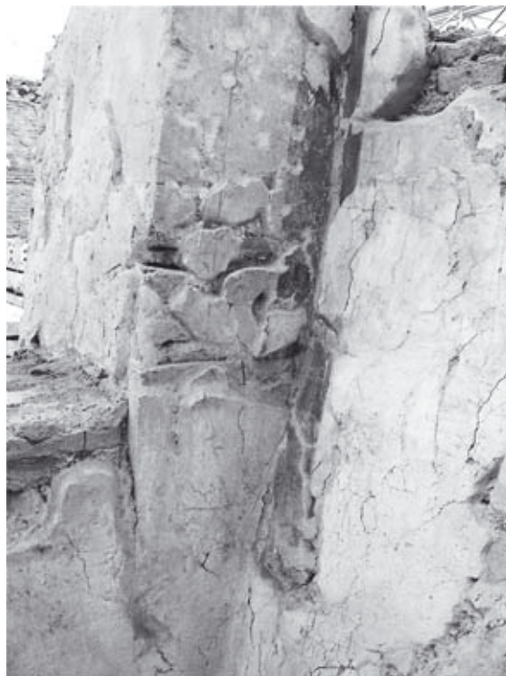
Abb. 15: 32e, NW-Ecke mit Baufuge
