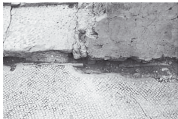
Abb. 16: 32e, an Marmorplatte vor W-Mauer angesetzter Mosaikboden
