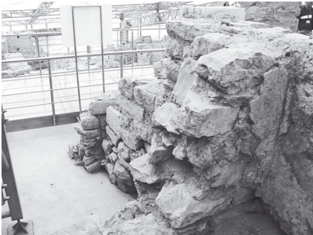
Abb. 43: 34b, NO-Ecke mit Putzschicht
